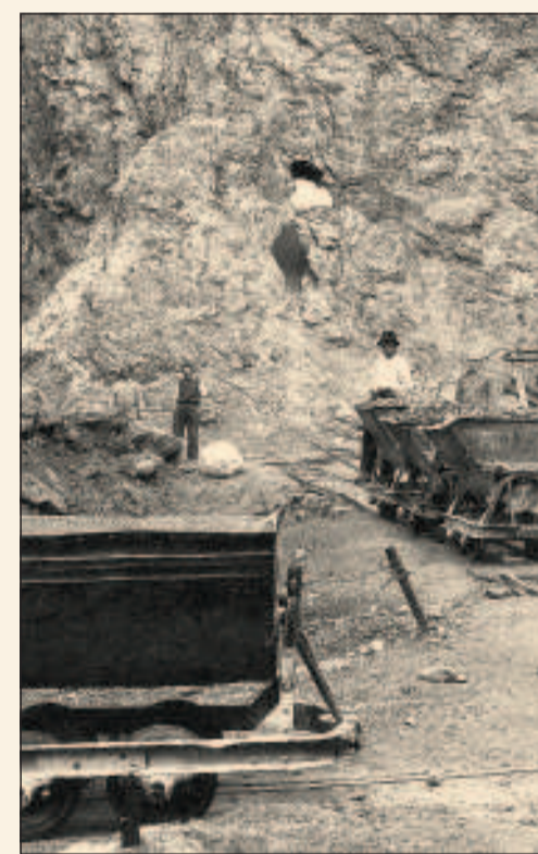
Per sfruttare i vasti giacimenti di dolomia presenti sulle montagne retrostanti Marone nacque nel 1919 la Dolomite Franchi spa. La dolomia, dopo l'estrazione e la frantumazione, veniva cotta in forni verticali funzionanti a carbone e ossigeno con temperatura che raggiungeva i duemila gradi. Il prodotto veniva esportato in tutti i mercati nazionali
